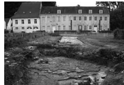
De fontein werd afgebroken tot haar onderste bodem in bakstenen in keperverband, juli 2006.
