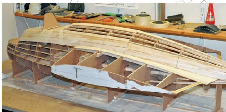
Marouflage au tissu de verre avant d'entreprendre les travaux de surfacage
